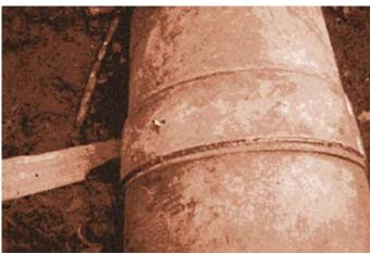
Рис. 8. Ремонт дефектного стыка на действующем магистральном газопроводе «Союз» Ду1400: а— сборка нахлесточно-стыковых соединений; б— внешний вид усиливающей двухслойной муфты
