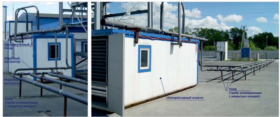
Рис. 3 — Система горизонтальная труба в трубе (ГТТ), в составе с компрессорно-конденсаторным агрегатом. Опытно-промышленный мерзлотный полигон, Тюмень Fig. 3 — The horizontal pipe-in-pipe system (GTT), composed of a condensing unit. Experimental industrial permafrost, Tyumen
