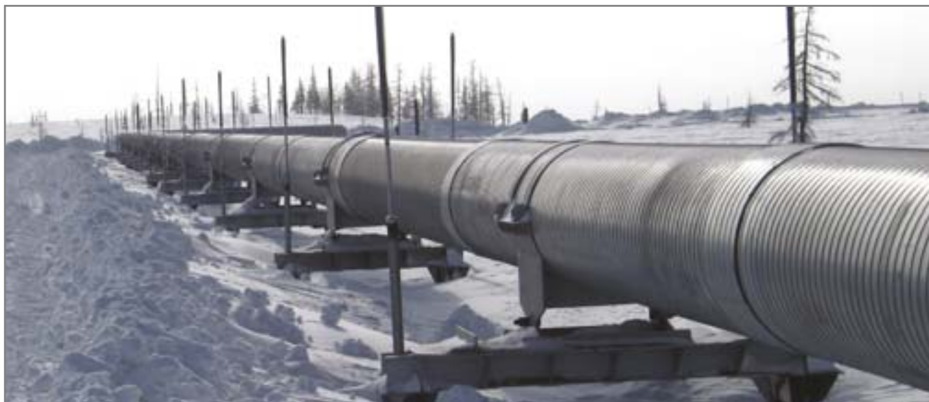
Магистральный нефтепровод полной комплектации предизолированный в заводских условиях
