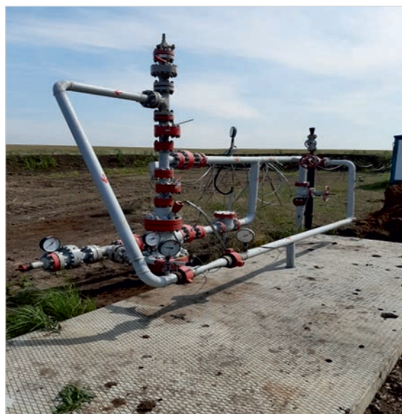
Фото 1. УСУ в устьевой обвязке скважины
