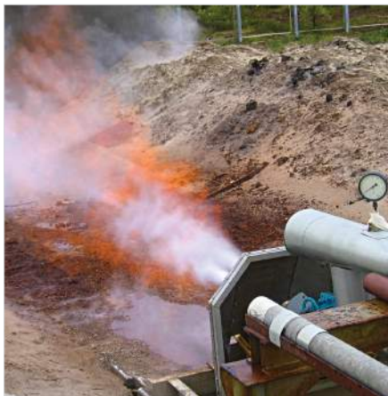
Рис. 1 — Установка ГФУ-5 на промысле
