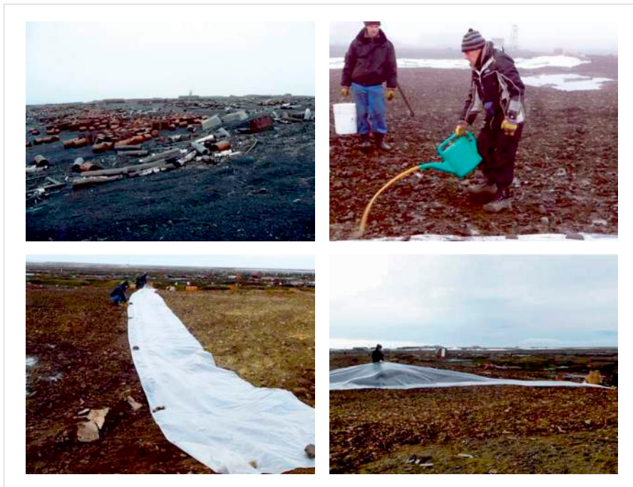
Рис. 1 — Обработка нефтезагрязненного участка биодеструктором Микрозим®
