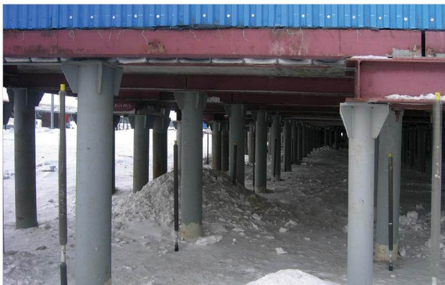
Рис. 1 — Здание с проветриваемым подпольем и одиночными термостабилизаторами
