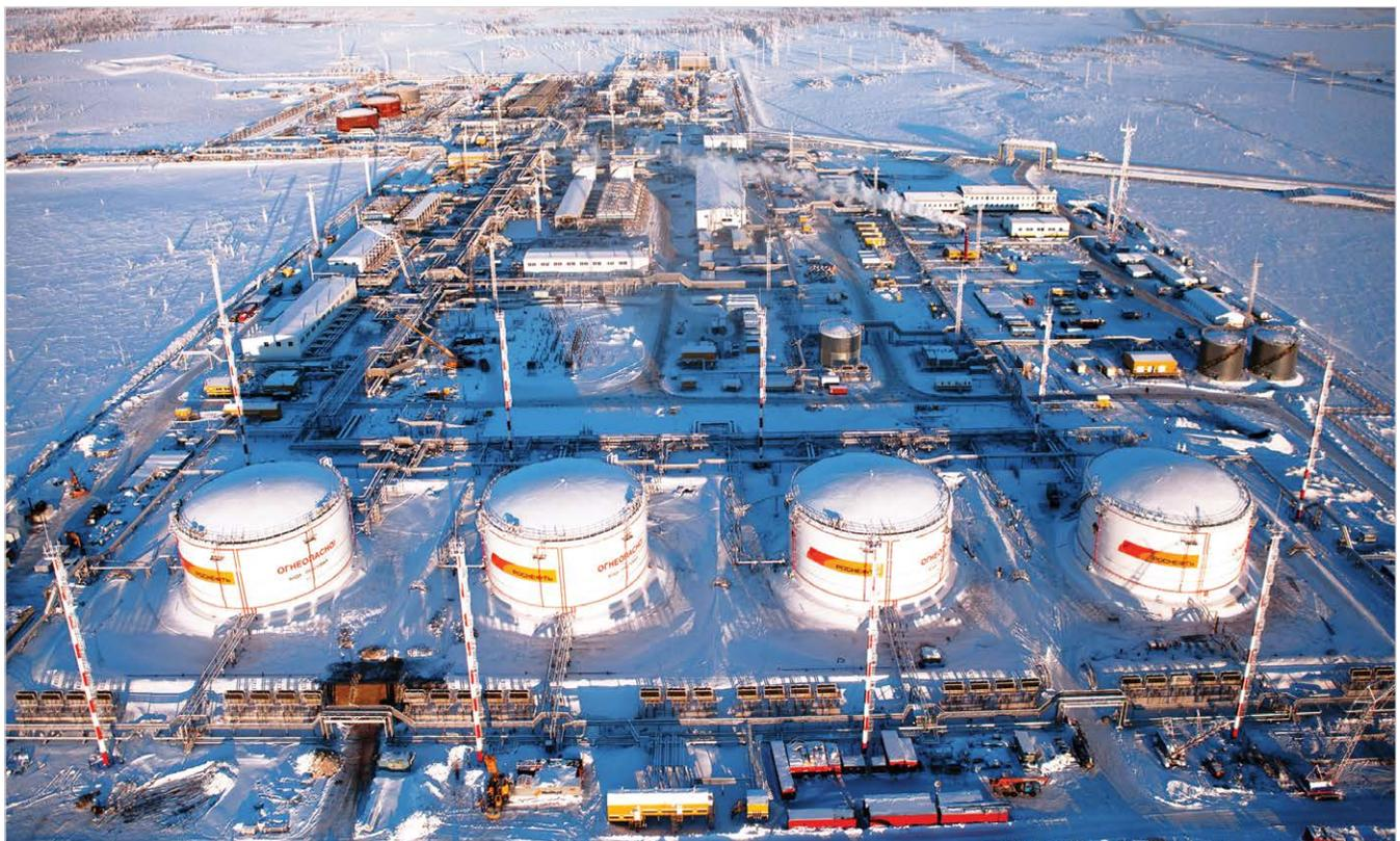
Рис. 6 – Бессвайные фундаменты с охлаждающими системами ГЕТ и ВЕТ в основаниях резервуаров
