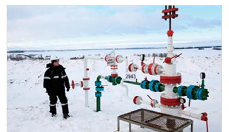
Рис. 5 — Устьевая арматура для ОРЗид и добычи
