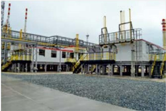
Фото 2. Установка подготовки топливного газа для объектов УКПГиК на Восточном Уренгое - основной (слева) и резервный модули
