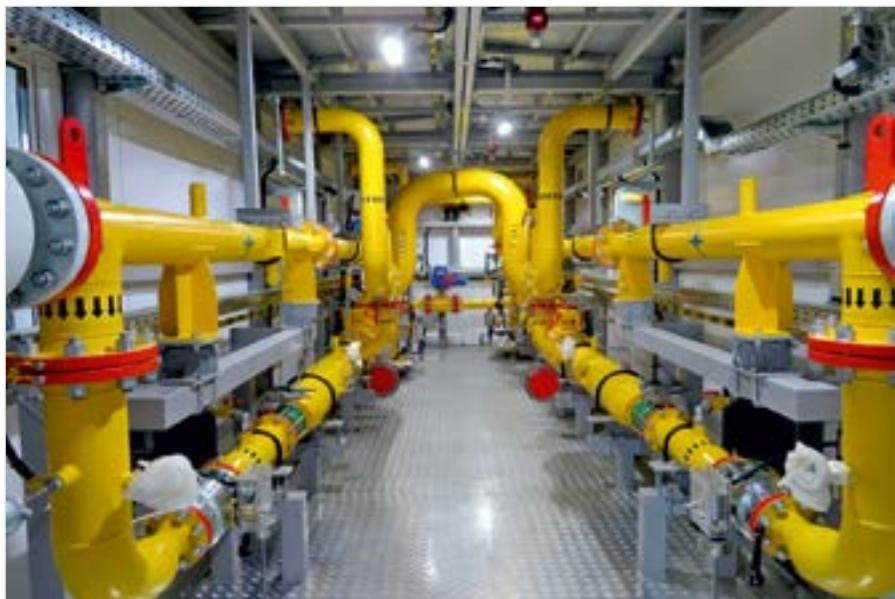
**Фото 3.** Газорегуляторный пункт обеспечит топливом печи прямого нагрева нефти на УПН «Уса-Тяжелая нефть»
