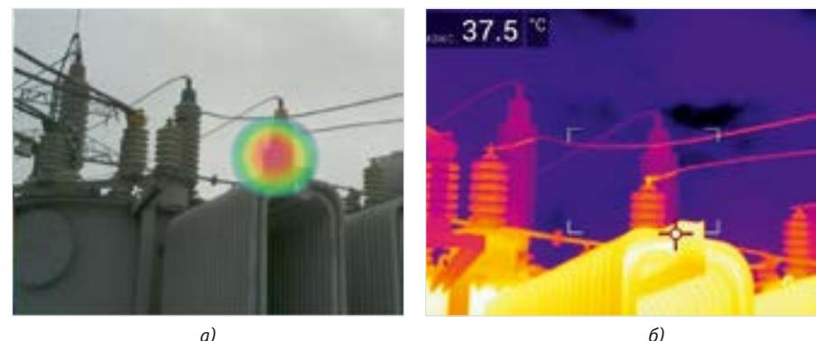
Рис. 1. Обследование трансформатора 110/35/6 кВ (С-1-Т)
