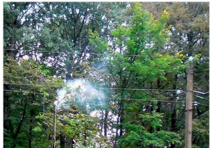
Рис. 6 — ОЗЗ на ВЛ с касанием веток дерева
