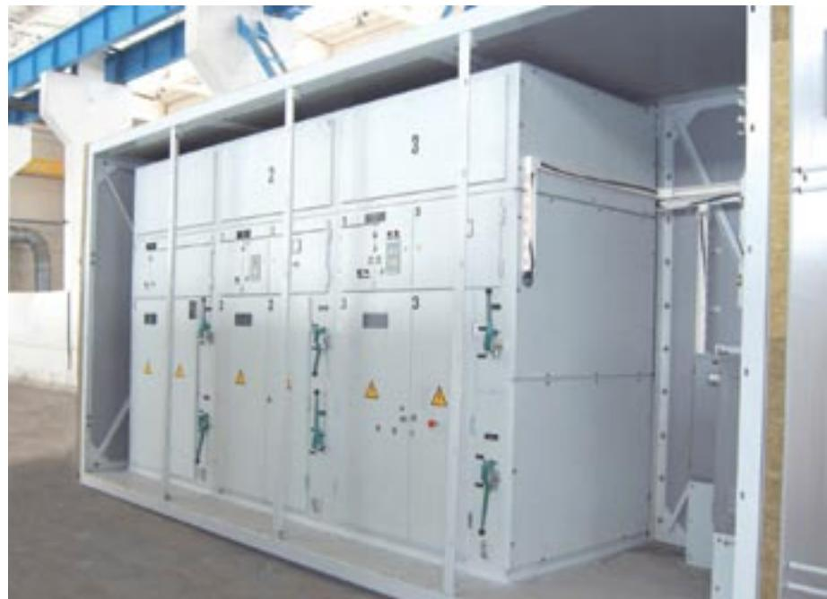
Рис.1. ЗРУ с ячейками 35кВ КТПБ (3) 35-6кВ
