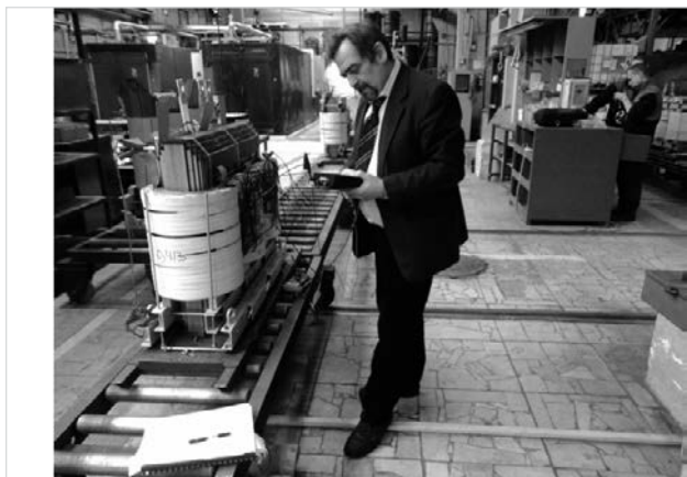
Рис. 4 — Проведение межоперационного контроля обмоток трансформатора на этапе сборки и монтажа прибором ALL-TEST IV PRO
