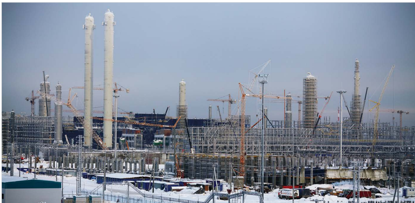
Площадка строительства ЗапСибНефтехима
