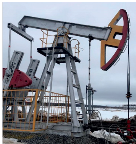
Фото 2. Компрессор скважинный, установленный на скважине
