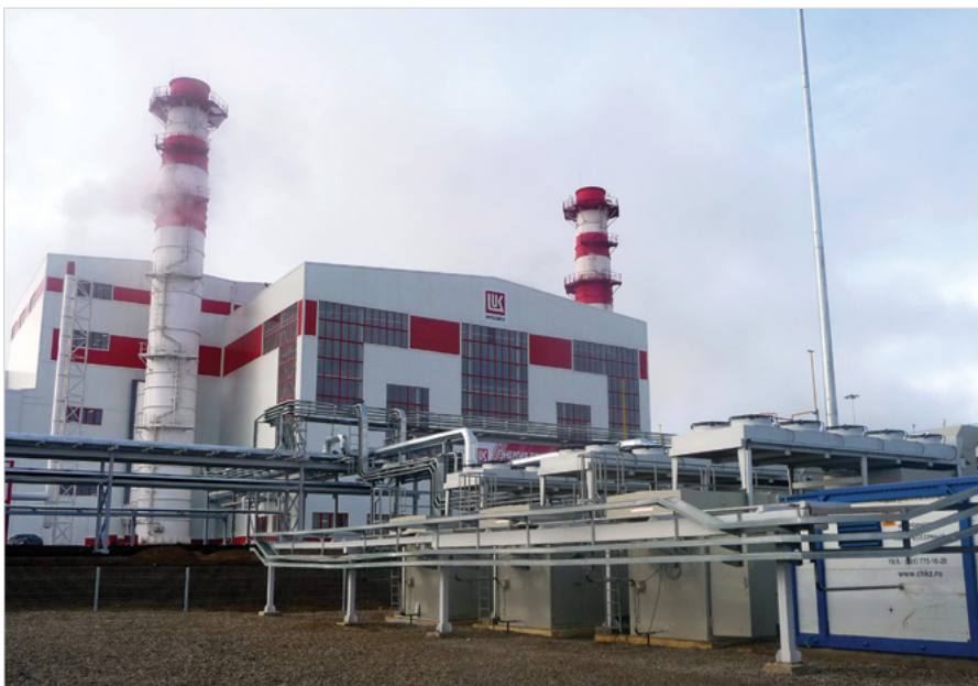
Фото 2. Компрессорная станция топливного газа для ПГУ-135 Буденновской ТЭС
