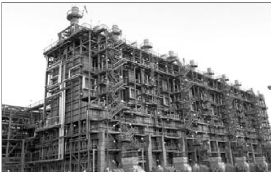
Рис. 5. Установка крекинга тяжелого нефтяного сырья (Германия) оснащенная системой визуализации и термографии высокотемпературных процессов
