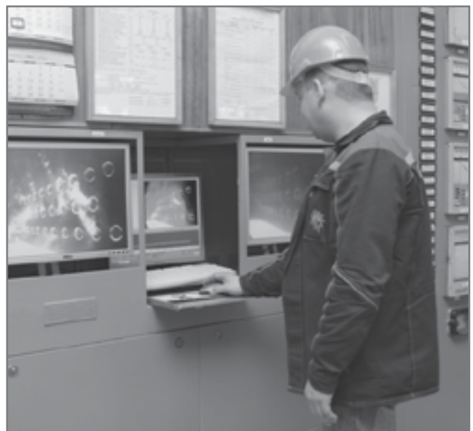
Рис. 2. Установка системы видеонаблюдения топочного пространства с функцией термографии на одном из предприятий отечественного ТЭК
