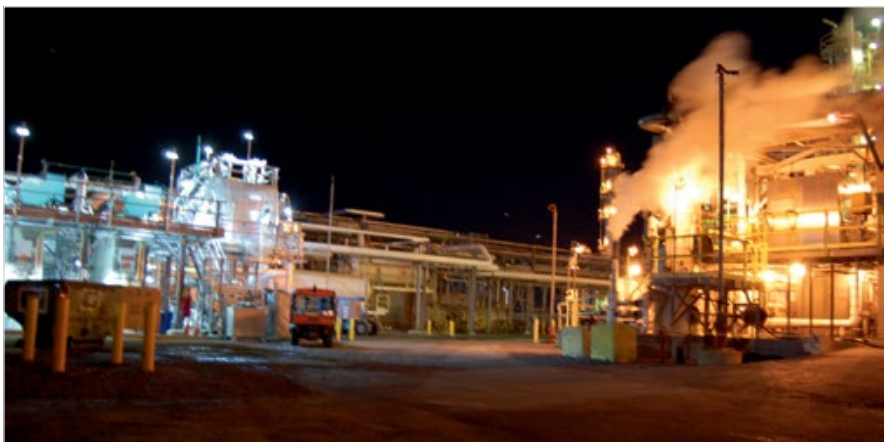
Рис. 2 — Нефтеперерабатывающий завод. Слева — светодиодные светильники Dialight. Справа — натриевые лампы высокого давления
