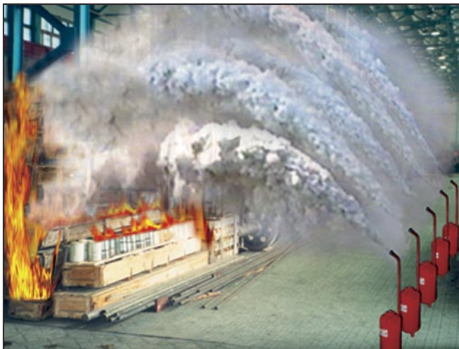
Рис. 3. Пример компоновки генераторов АГАТ-2А в батарее по 8-10 штук (защита объема 1500...2000 м³)
