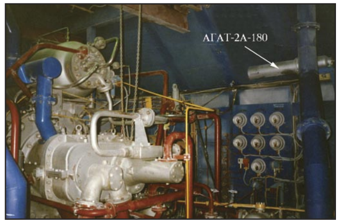
Рис. 4. Пример установки одиночных генераторов АГАТ-2А в затененные места объекта
