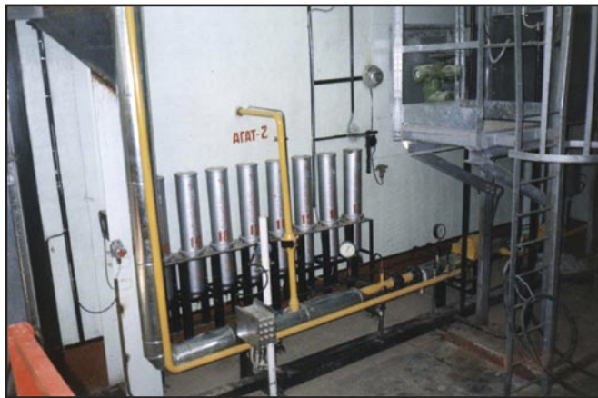
Рис. 3. Пример компоновки генераторов АГАТ-2А в батарее по 8-10 штук (защита объема 1500...2000 м³)
