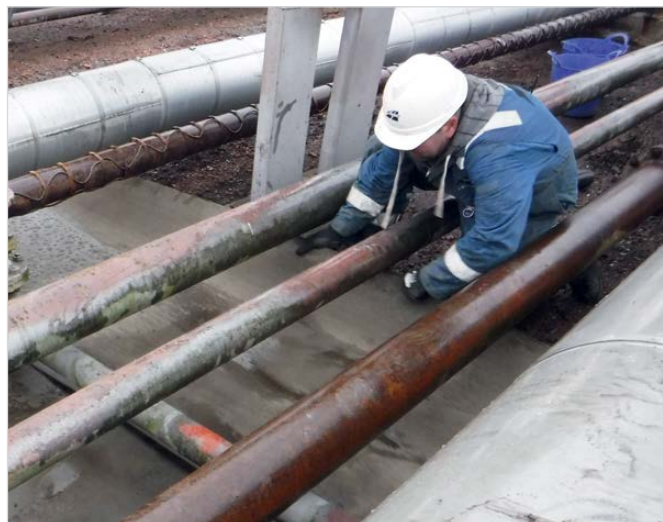
Рис. 4 — Стыковка отрезков полотна внахлест
