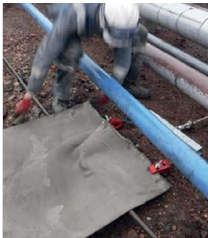
Рис. 2 — Крепление бетонного полотна к протяжному приспособлению
