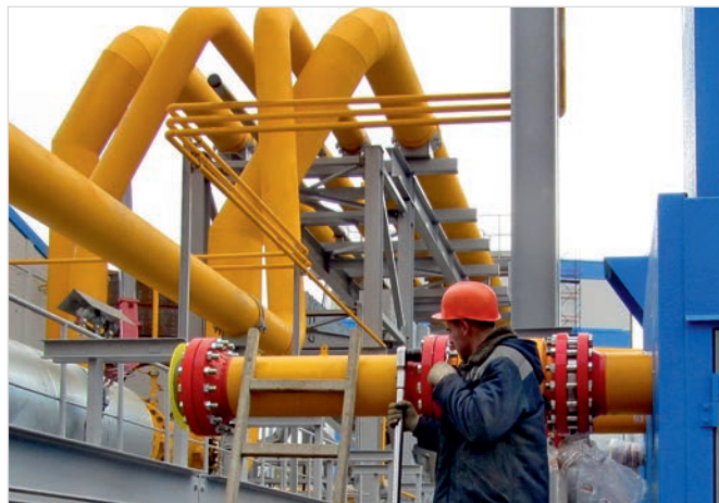
Фото 2 — Строительно-монтажный этап. Трубопроводная обвязка компрессорной установки
