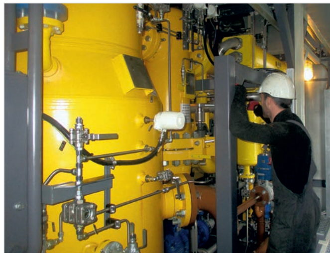
Фото 10 — Комплексное техобслуживание оборудования газоподготовки для ГТУ-ТЭЦ «Уса» выполняется в рамках Программы долгосрочного сервиса
