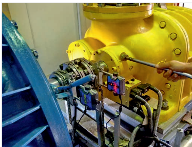
Фото 7 — Наладка оборудования после проведения капитального ремонта
