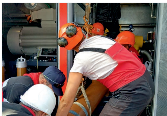
Фото 4 — Пусковая установка для ГТЭС Восточно-Перевального м/р. Закладка элементов маслосистемы после промывки и модернизации
