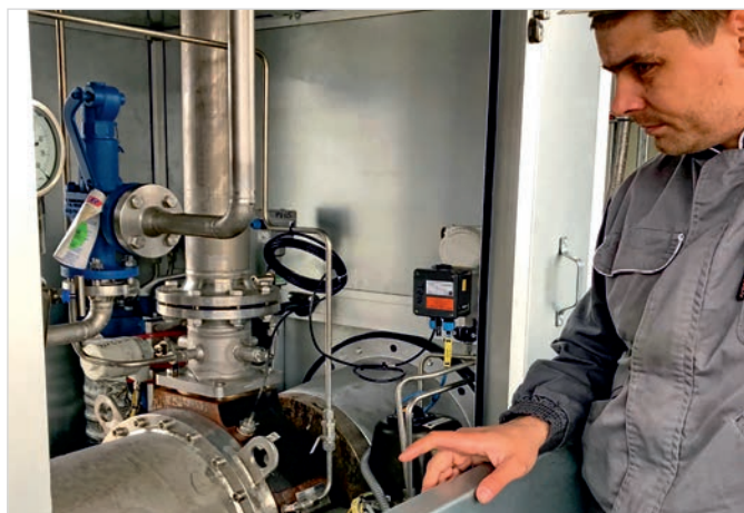
Фото 3 — Собственные испытания оборудования завершают этап пусконаладочных работ
