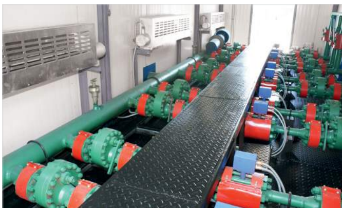
• Блок гребёнок для регулируемой подачи воды в системе поддержания пластового давления (ППД)
