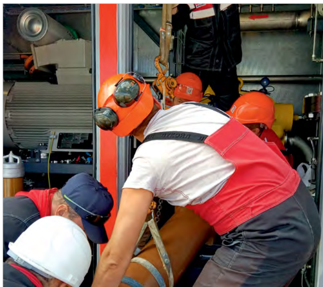
Фото 7 — Пусковая установка для ГТЭС Восточно-Перевального м/р. Закладка элементов маслосистемы после промывки и модернизации
