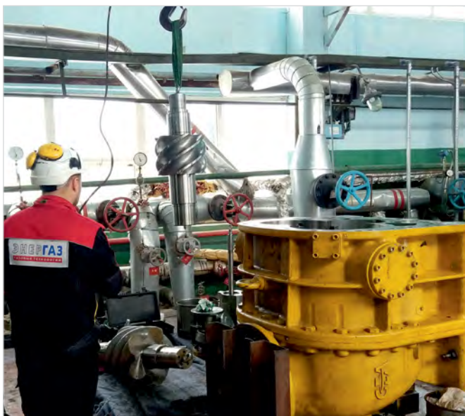
Фото 11 — Капремонт газового компрессора на Южно-Сахалинской ТЭЦ-1. Работы выполнены в рамках Программы долгосрочного сервиса
