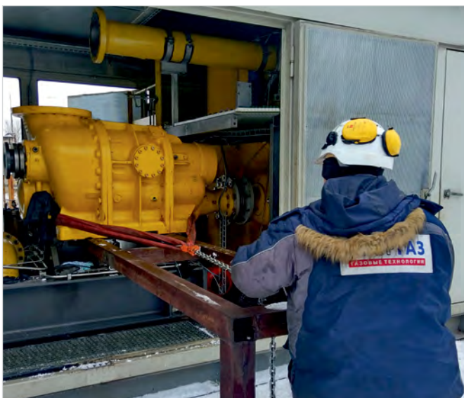
Фото 5 — Демонтаж оборудования газоподготовки в ходе ремонтных работ на ПГУ-225 Сызранской ТЭЦ
