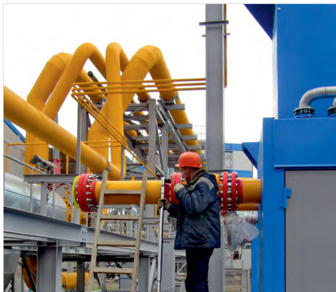
Фото 2 — Строительно-монтажный этап. Трубопроводная обвязка технологической установки
