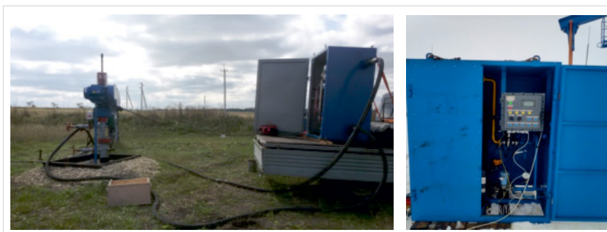
Рис. 1. Проведение замеров при помощи БИПС Fig. 1. Performing measurements using BIPS
