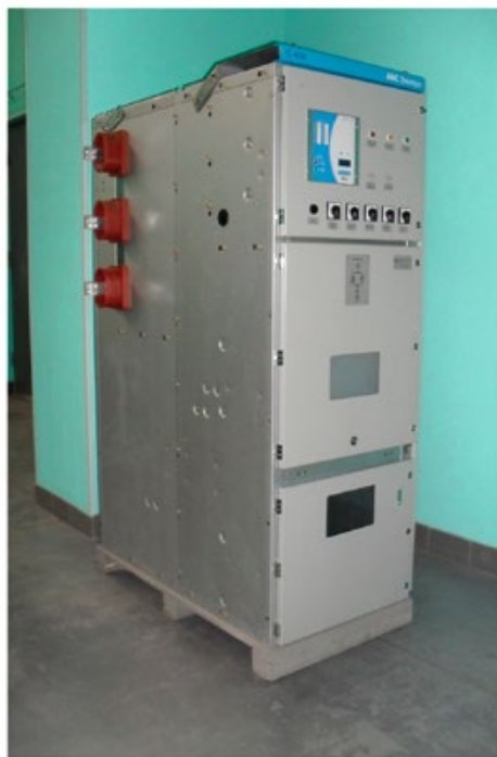
Рис. 3 — Внешний вид УТВР в ячейке С-410
