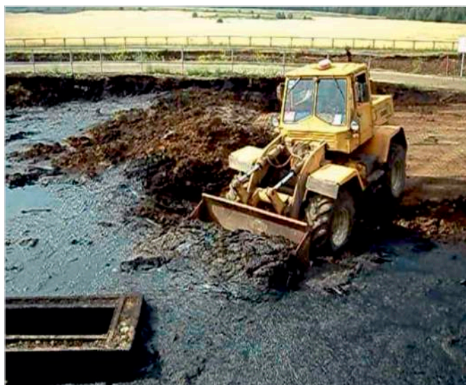
Забор шлама ковшовым погрузчиком. Время погрузки 1,5 кубов шлама — около 2 минут. Позади техники видно практически чистое дно амбара
