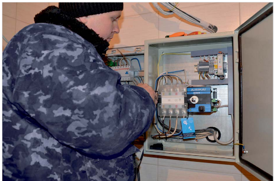
Фото 7 — Монтаж шкафа АВР (автоматический ввод резерва)
