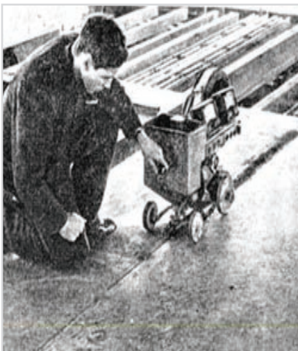
Рис. 5 — Автоматическая сварка под флюсом плоскостных конструкций трактором ТС-17
