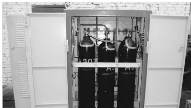
Рис. 3 — БАД на сборочной площадке (вид сзади)
