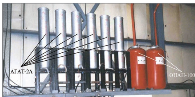
Рис. 1, 2 Комбинированная система аэрозольно-порошкового пожаротушения в укрытии газоперекачивающего агрегата COBERROW (предприятие «Сургутгазпром»)
