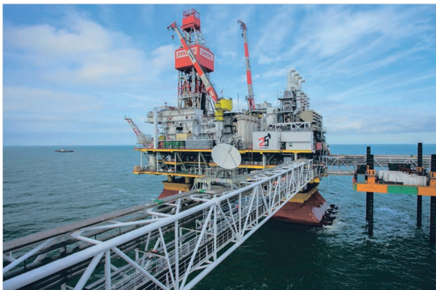
«ССТЭнергомонтаж» (входит в ГК «ССТ») поставила системы электрообогрева для объектов шельфового месторождения им. В. Филановского
