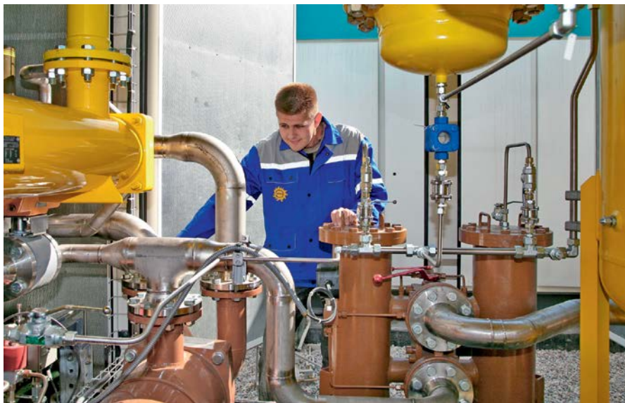
Фото 6. Предпусковые работы на компрессорной станции топливного газа
