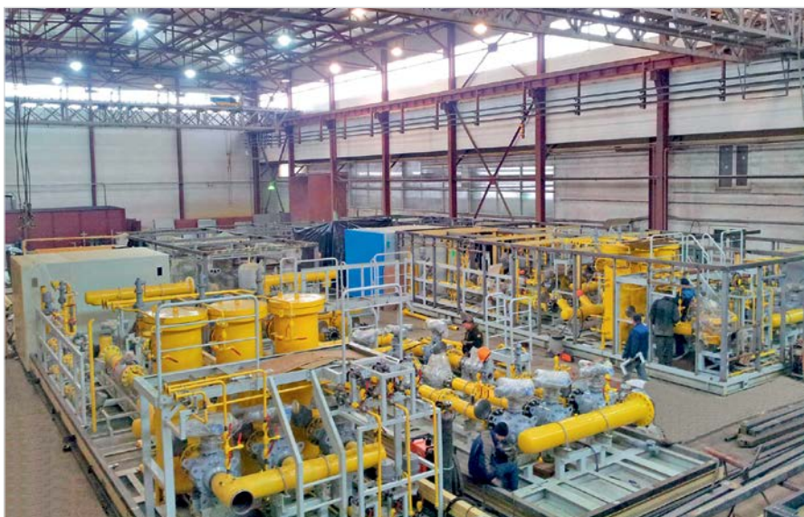
Фото 5. Сборочный цех. Подготовка оборудования к заводским испытаниям
