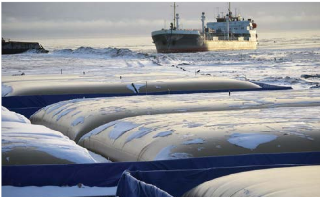
ПСГ-17500, Ямал, Сабетта. Эксплуатируется 4-й год, объем переваленного топлива — 70000 м 3
