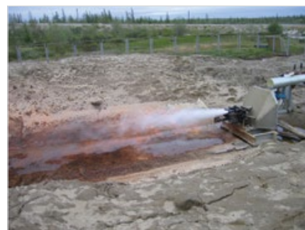
Рис. 4 — Установка ГФУ-5 на промысле
