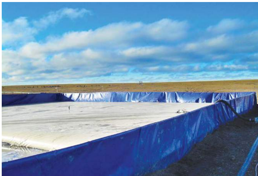
ПСГ-5000 на базе эластичных резервуаров, Хатангский лицензированный участок на мысе Косистый
