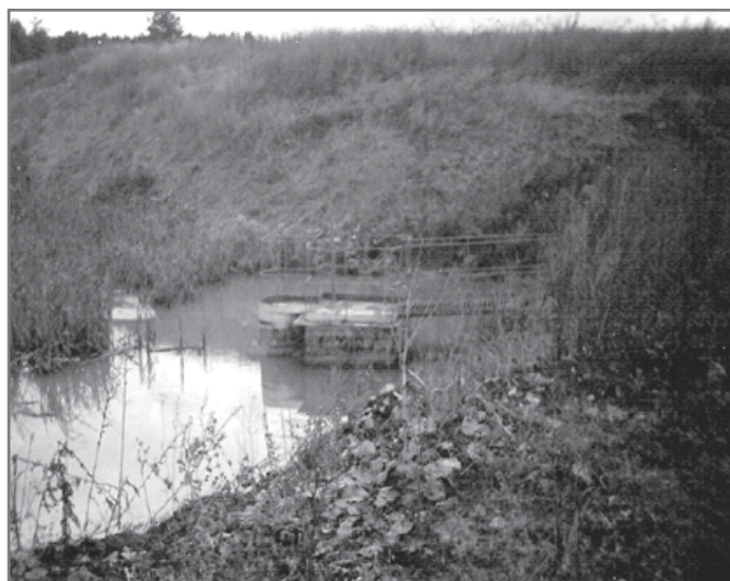
Рис.2. Нефтеловушечная плотина упрощенного типа после 6 лет эксплуатации
