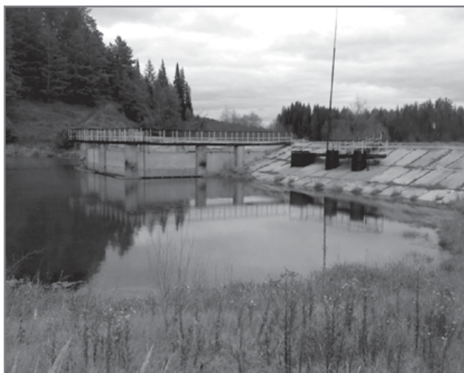
Рис.3. Капитальное гидротехническое сооружение – нефтеловушечная плотина
