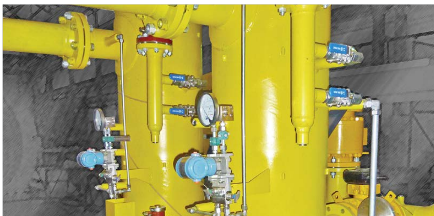
Фото 5. Двухступенчатые коалесцирующие фильтры-сепараторы
