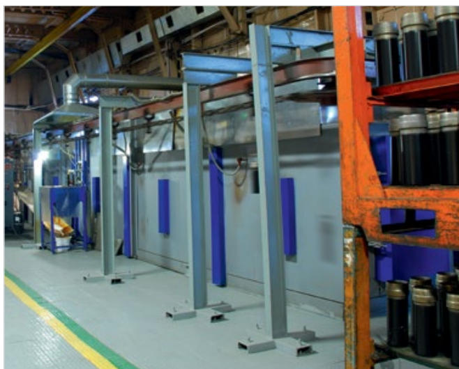
Рис. 3 — Линия по нанесению покрытия
