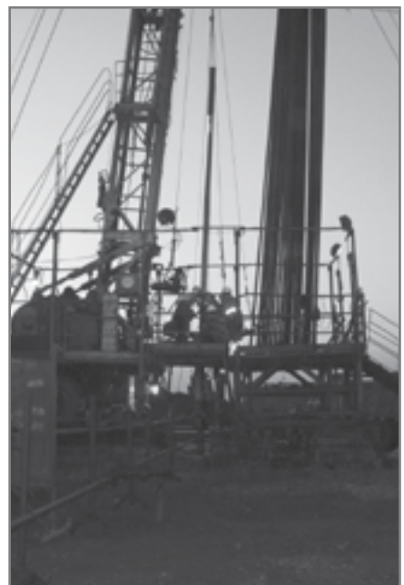
Рис. 3 Сборка отклонителя и спуск его в скважину
