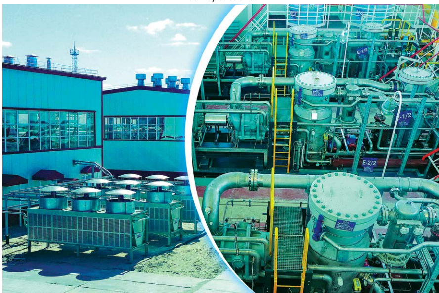
Фото 6. Компрессорная станция снабжает попутным газом турбины ГТЭС-36 на Северном Лабатьюгане
