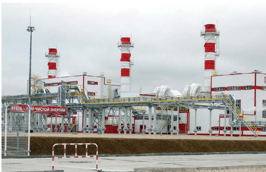
Фото 7. Энергоцентр «Ярега». В качестве топлива для ГТУ-ТЭЦ используется природный газ
