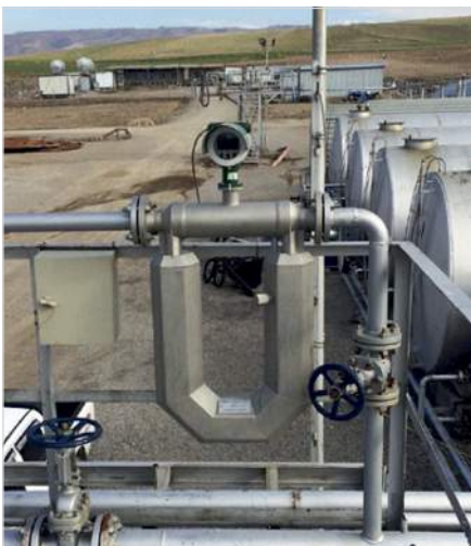
Рис. 3 — Массовый расходомер ЭМИС-МАСС 260 Ду 50 в узле налива нефтепродуктов
