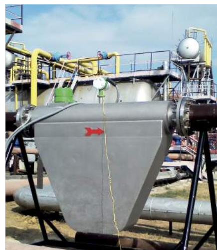
Рис. 2 — Массовый расходомер ЭМИС-МАСС 260 Ду 200 в установках подготовки нефти
