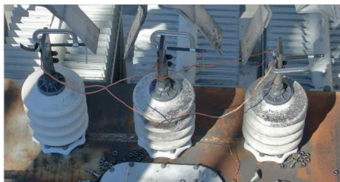
Рис. 2 — Пример закорачивания выводов вторичной обмотки
