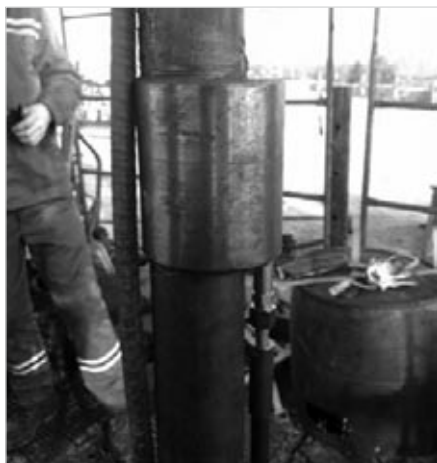
Рис. 2 — Установка вводной муфты
