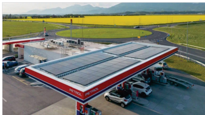
Рис. 6. Использование солнечной энергии (солнечных панелей) на АЗС компании «Petrol Group» [17] Fig. 6. The use of solar energy (solar panels) at the petrol station of the company «Petrol Group» [17]
