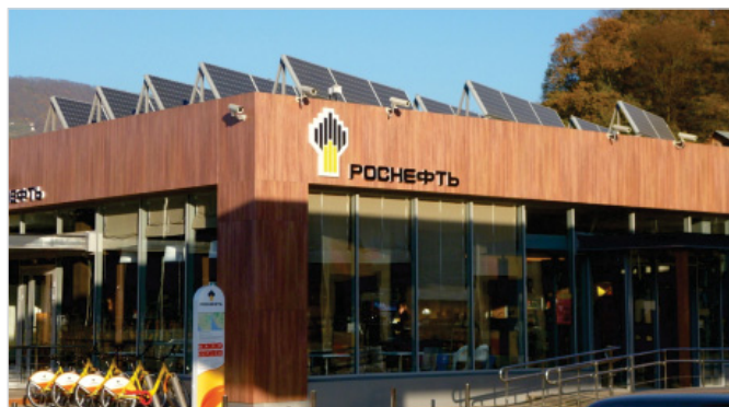
Рис. 5. Пример размещения солнечных панелей на крыше павильона АЗС Fig. 5. The example of placing solar panels on the roof of a gas station pavilion
