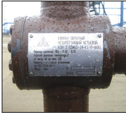
Рис. 2. Клапан КОНЗ. Общий вид
