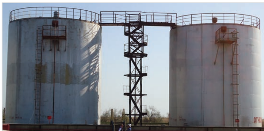
Рис. 3 — Резервуары для хранения углеводородов и пластиковой воды
