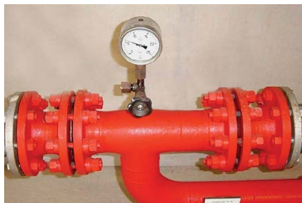
Рис. 1 — Изолирующее фланцевое соединение
