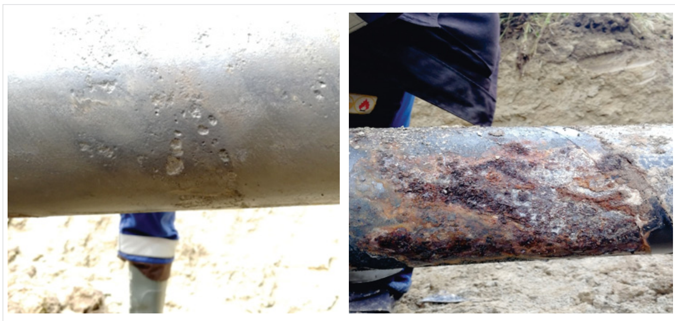
Фото 1. Визуальный осмотр на Интервале № 1 Photo 1. Interval № 1 visual inspection
