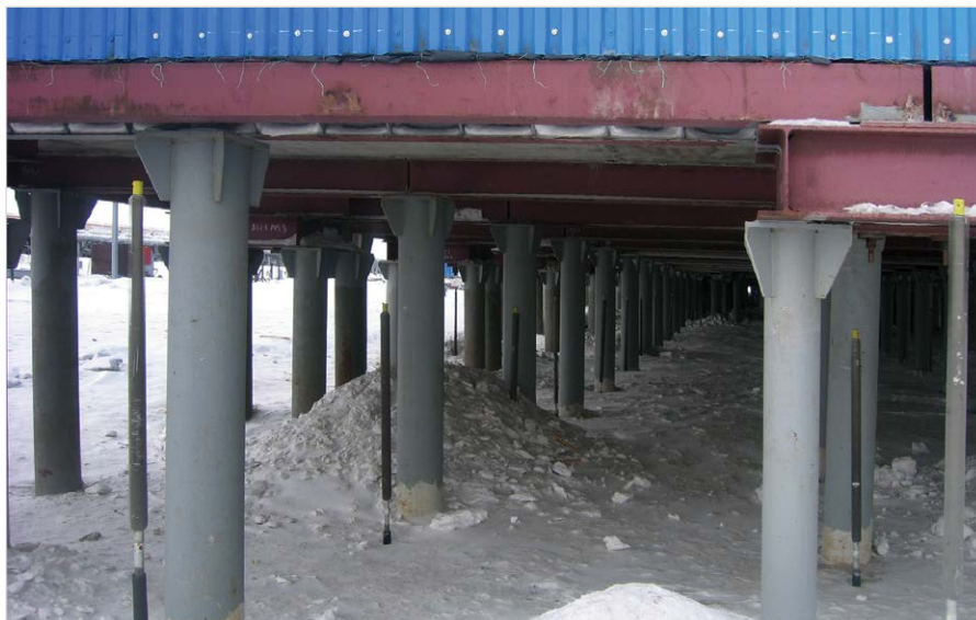
Рис. 1 — Здание с проветриваемым подпольем и одиночными термостабилизаторами
