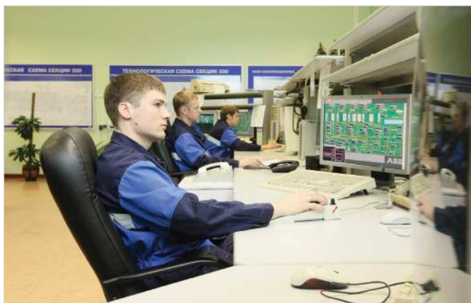
Рис. 2 — В операторной комплекса по облагораживанию моторных топлив
