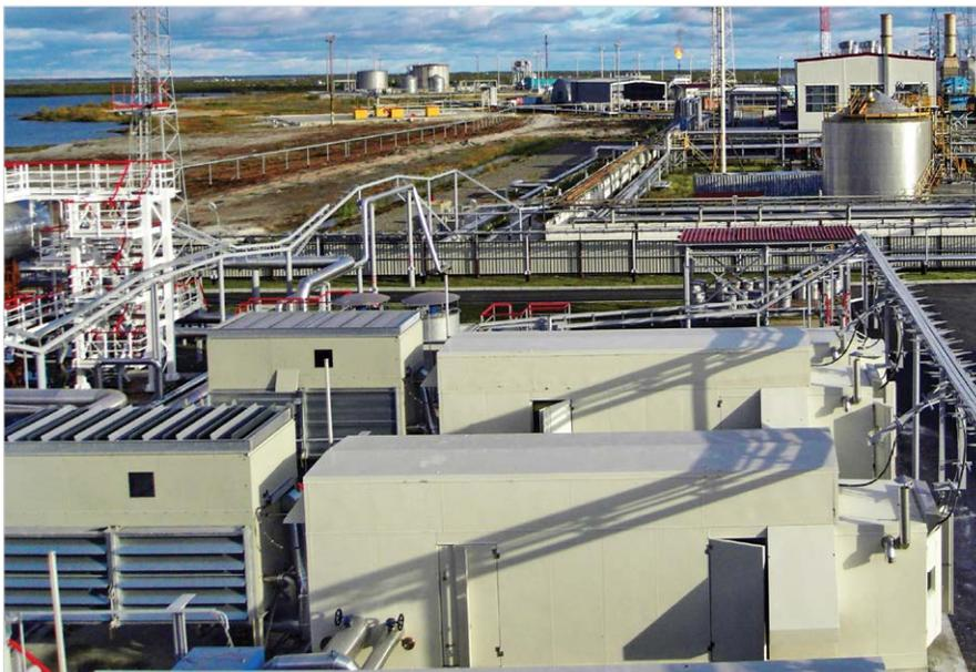
Фото 1. Компрессорные установки Битумского месторождения (ОАО «Сургутнефтегаз») для транспортировки ПНГ
