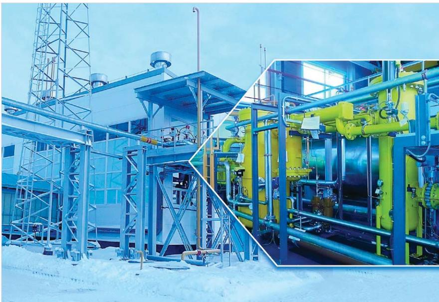
Фото 2. Установка подготовки топливного газа «ЭНЕРГАЗ» для ГТЭС-12 Игольско-Талового м/р (ОАО «Томскнефть»)
