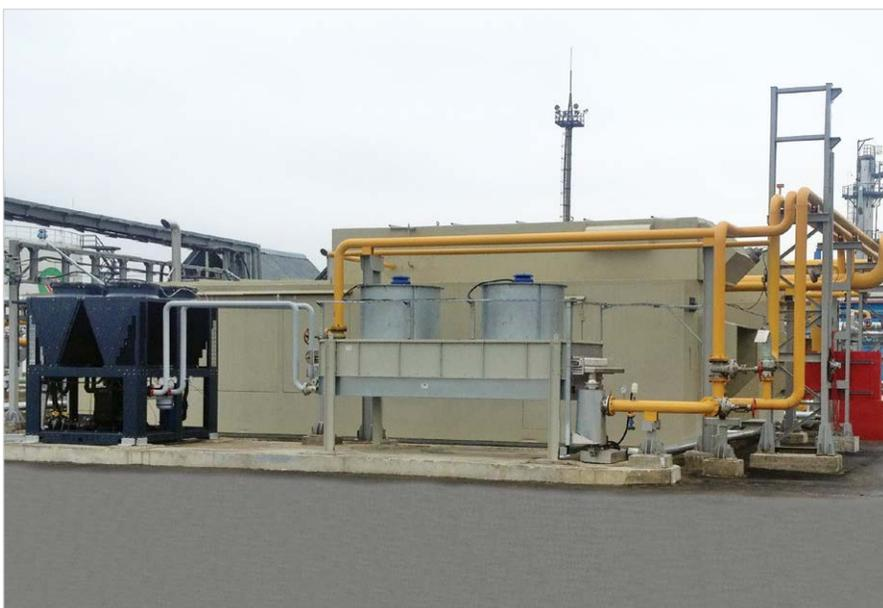
Фото 8. Рефрижераторная установка газоохлаждения в составе системы подготовки ПНГ
