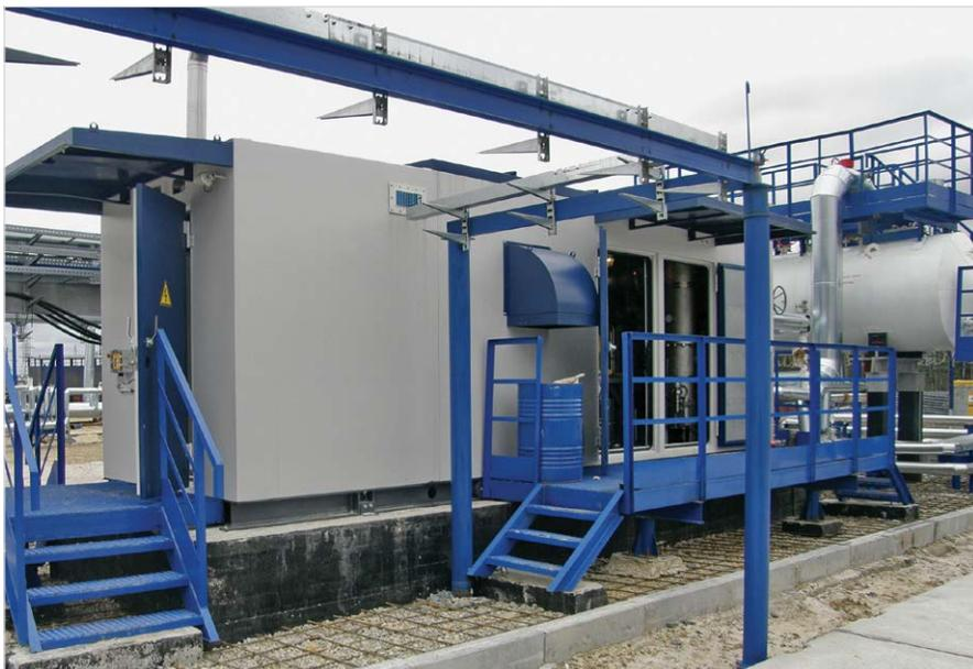
Фото 4. Вакуумная КС «ЭНЕРГАЗ» на Вынгапуровском промысле (ОАО «Газпромнефть-ННГ»)
